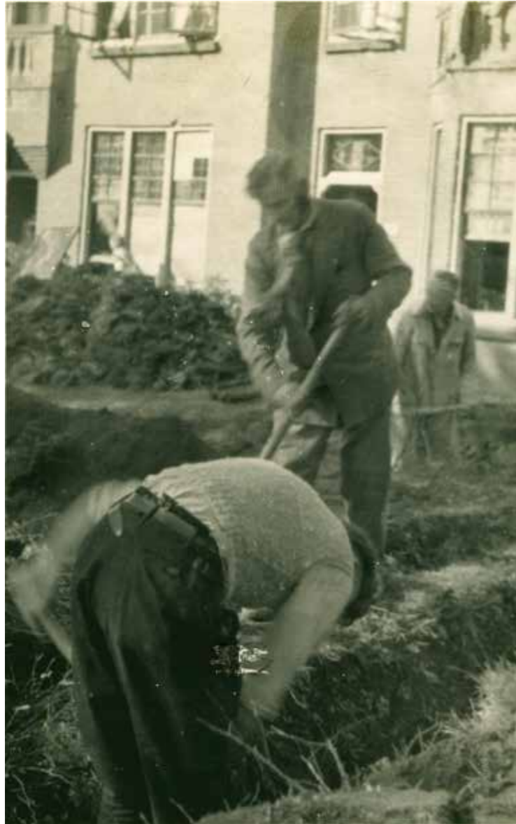
NSB'ers verrichten herstelwerkzaamheden. Bron: Streekarchivariaat Noordwest-Veluwe, 4901 Fotocollectie Ermelo, Andries Jansen, 16778; fotograaf: Andries Jansen, Ermelo.
