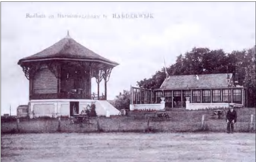
Harmoniegebouw (de muziekkoepeel) en het Badhuis (later Harniniegebouw) aan de Diepegracht
