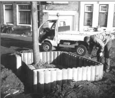
Plaatsing hoge betonnen plantenbakken
